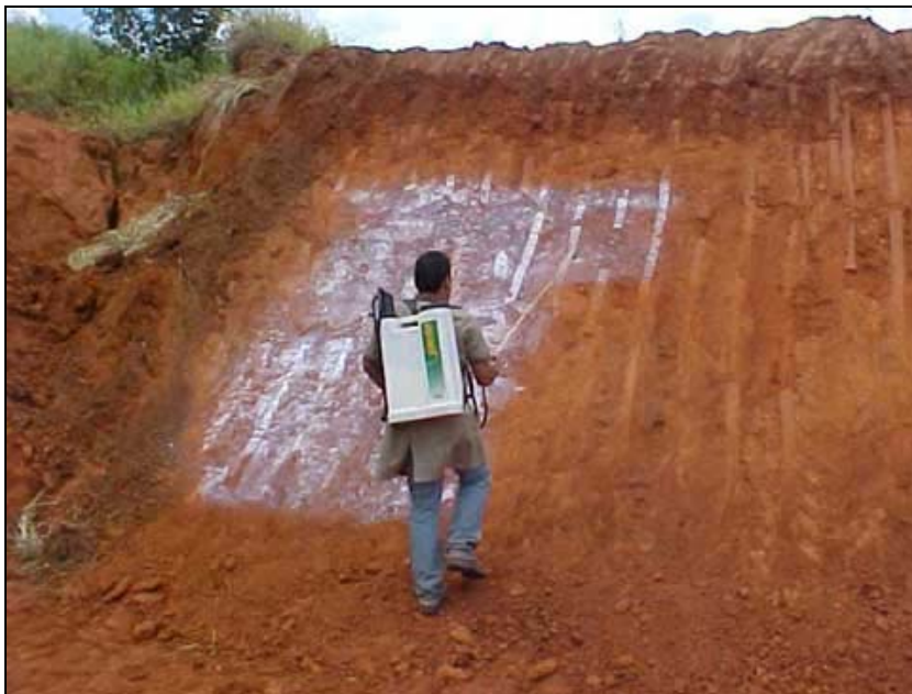
Primeira demão sendo aplicada nos testes com pulverizador costal manual
