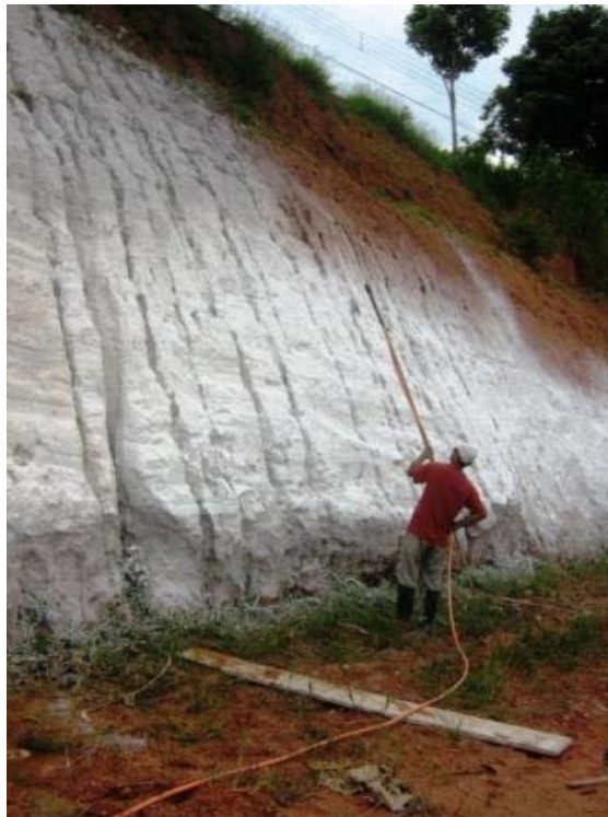
A lança presa em uma haste de madeira leve como expediente para se atingir alturas maiores
