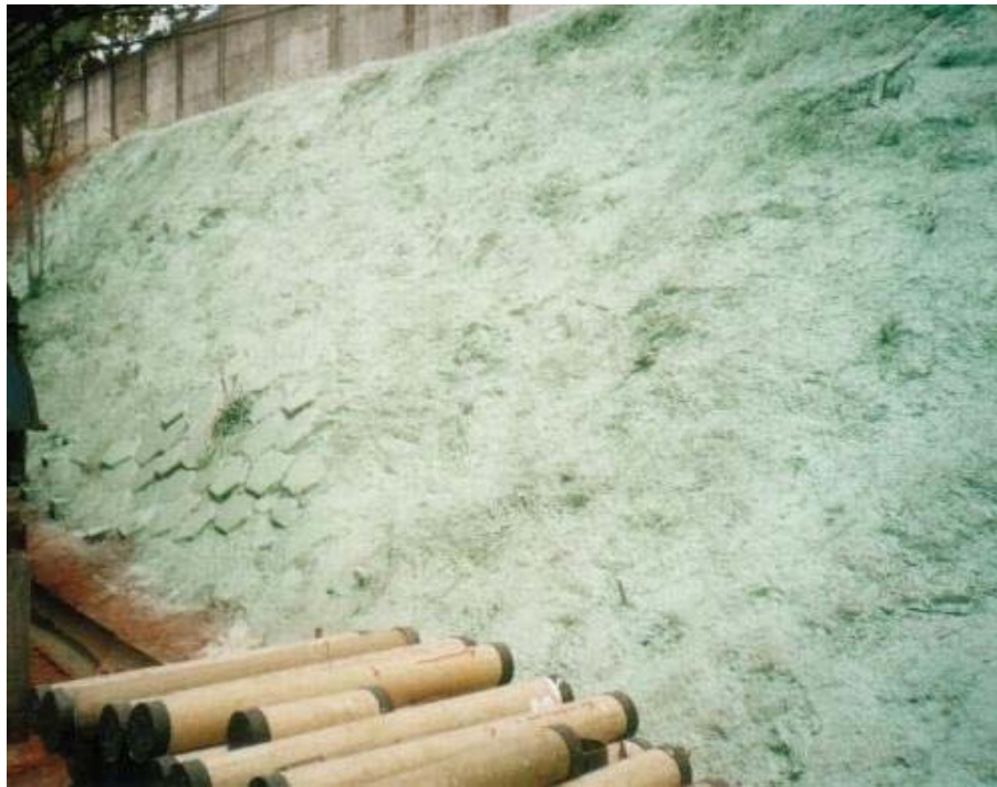
Pulverizador motorizado - pintura concluída com aplicação de 2ª demão pigmentada
