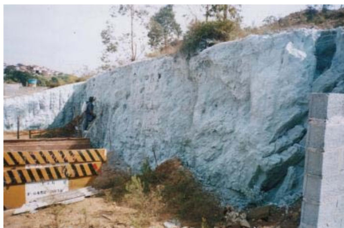
Talude protegido
