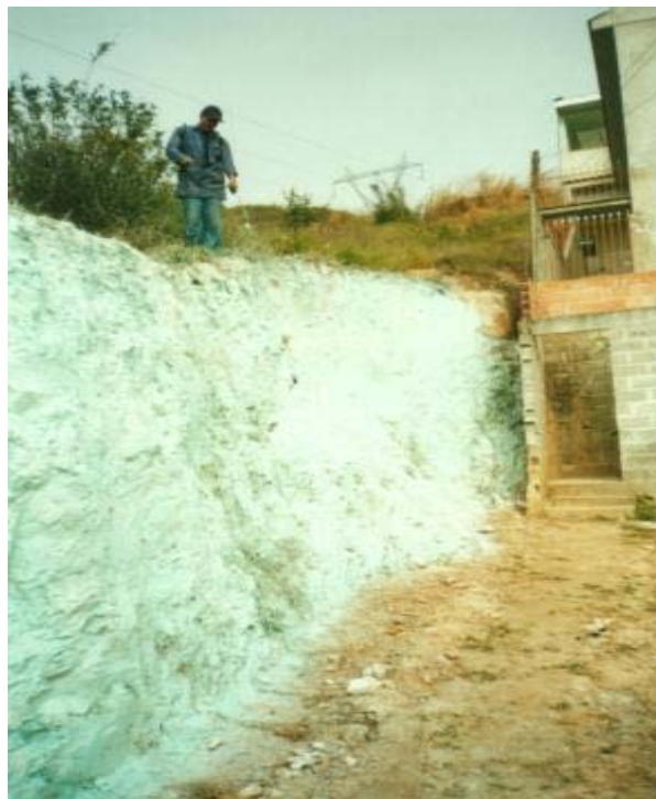
2ª demão pigmentada já aplicada. Arremate da pintura pela crista do talude
