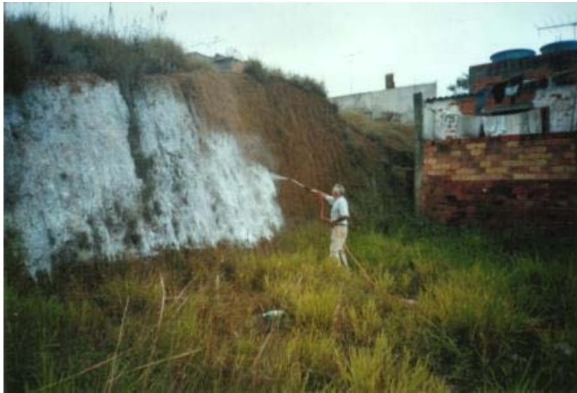
Mangueira de 30 metros do pulverizador motorizado permitindo um grande raio de alcance
