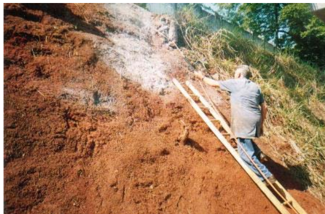
Escada apoiada no talude permitindo acesso a alturas maiores
