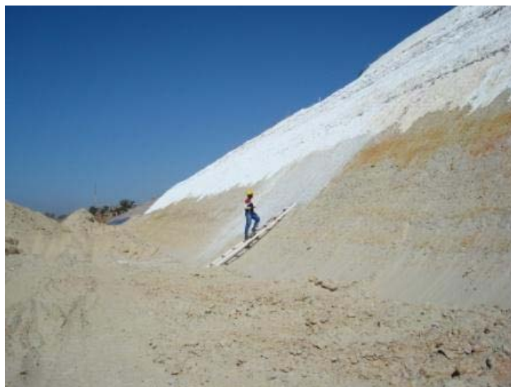
Grande talude protegido concomitantemente com o avanço da terraplenagem
