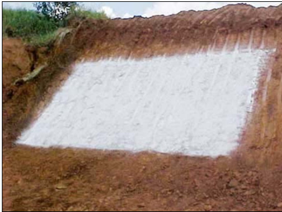
Pintura concluída como o costal manual
