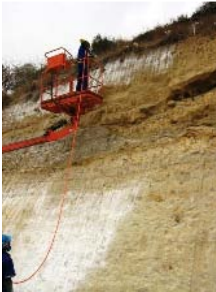
Pintura em alturas maiores
