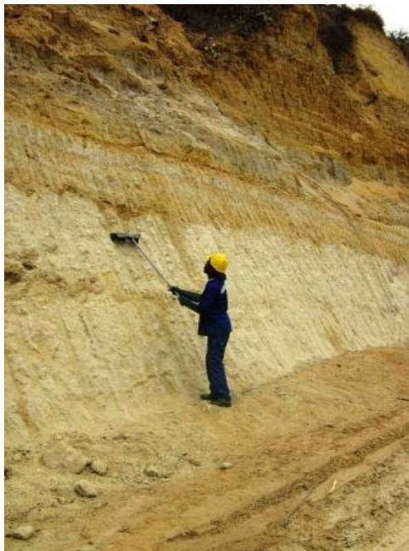
Operação de limpeza do talude
