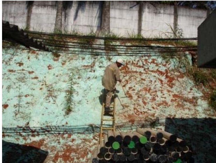
Talude sendo escarificado com ancinho para receber proteção vegetal
